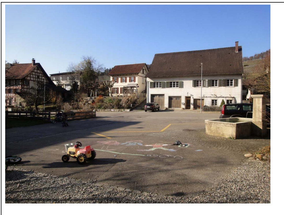
Abbildung 2: Sicht Richtung Nordwest zum ehemaligen Kindergarten, mit der Dorfstrasse dazwischen
